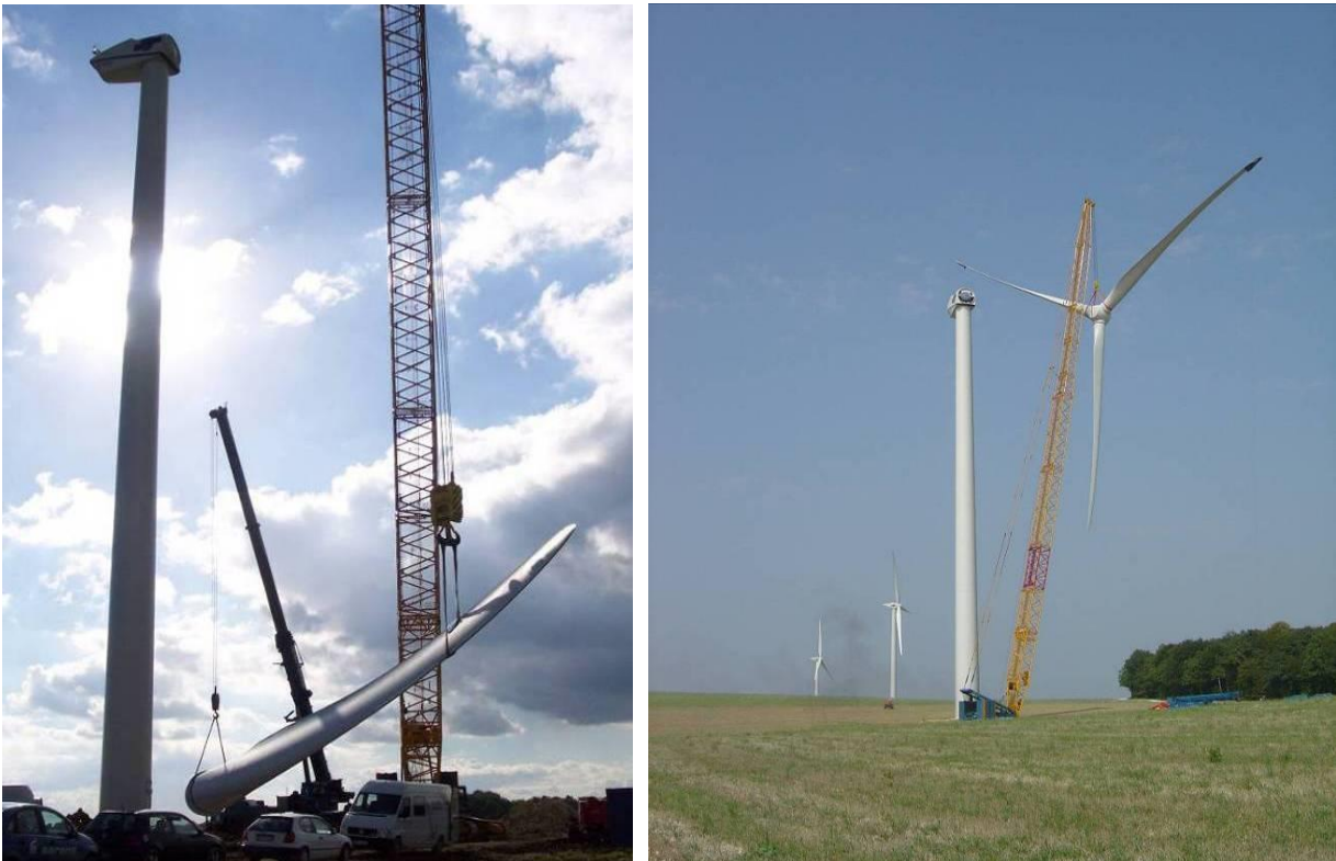
Figure 12 : Grue de montage et élevage du rotor
