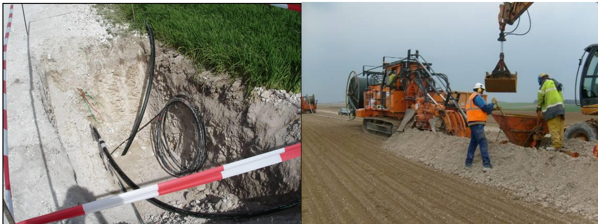
Figure 14 : Photos d'une tranchée pour l'enfouissement des câbles électriques
