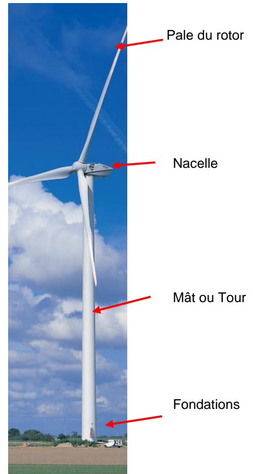
Figure 7 : Description d'une éolienne
